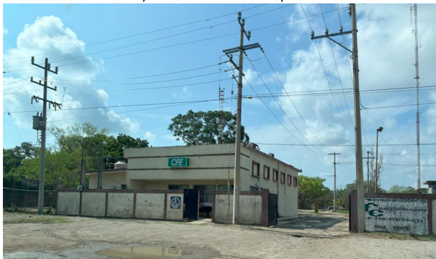
Imagen 19.- Subestación Aldama, División Golfo Centro, Zona Mante
