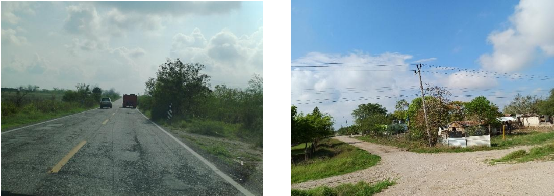
Imagen 28.- Tipo de vialidades pavimentada y no pavimentada
